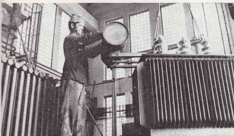
Kontrola množství oleje v konzervátoru vlastní spotřeby před odesláním z OTT
