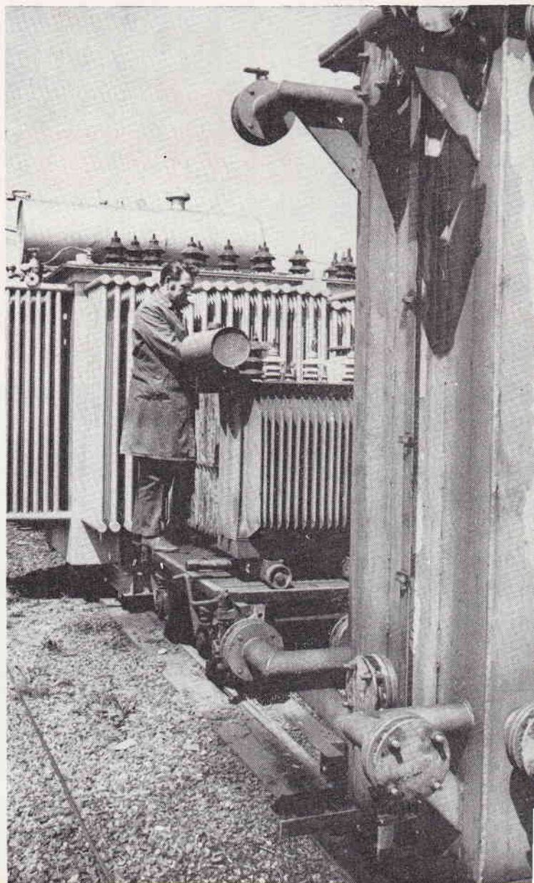
Kontrola těsnosti průchodek na prostranství opravy trakčních transformátorů
