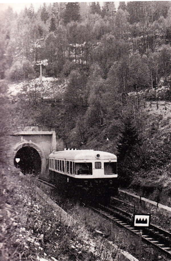
Vjezd do tunelu pod Kořenovem, kde začíná ozubnice. Říjen 1976
